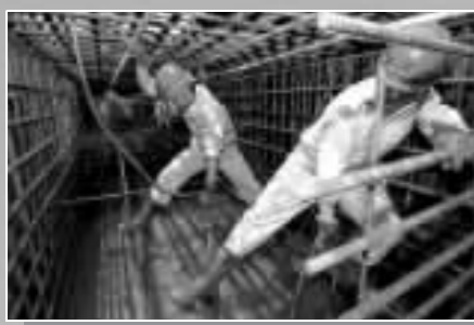
5月19日,施工人员在浇筑仓内振捣三峡大坝最后一仓混凝土
