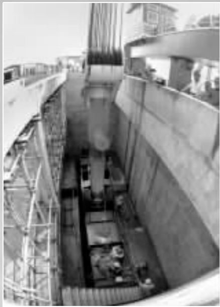
5月18日,三峡大坝最后一套挡水闸门吊装成功
