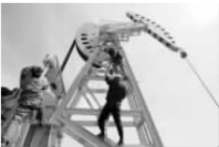
5月22日,河北华北油田工作人员正在维修一组油泵
