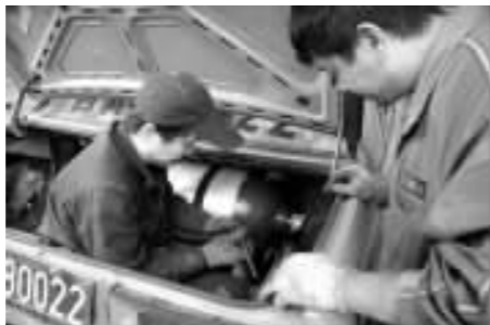
5月25日,兰州,一位技术工人在出租车后备箱内安装压缩天然气钢瓶
