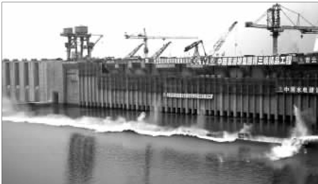
6月6日,三峡工程三期围堰实施爆破拆除 图为爆破瞬间 新华社图
