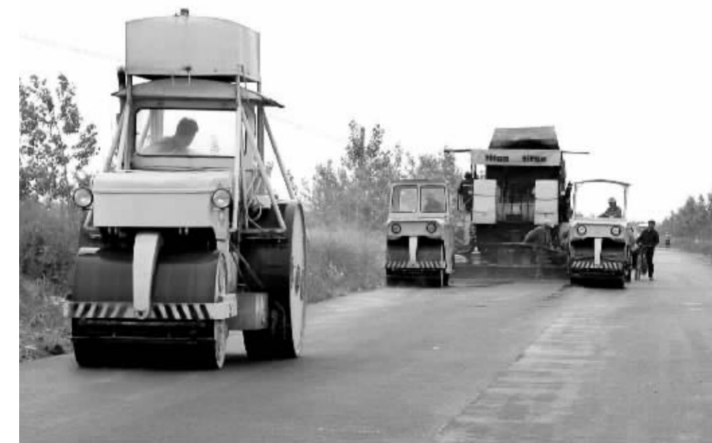
图为江苏省大丰市农村公路建设现场 资料图
