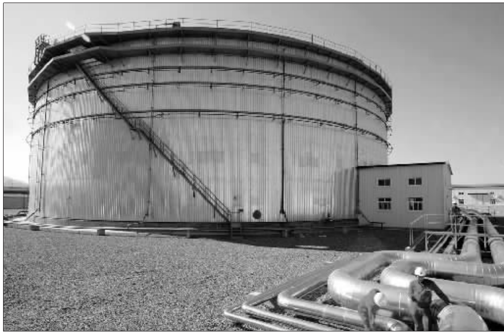
图为新疆维吾尔自治区博乐市的工人在托托石油传输站检查管道 资料图
