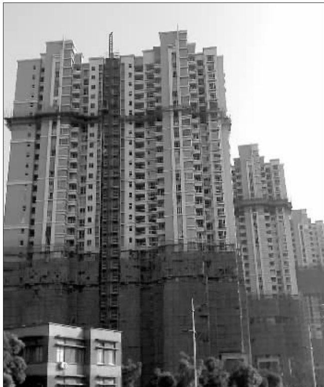
今年起交房的中海瀛台正在建设中 资料图
