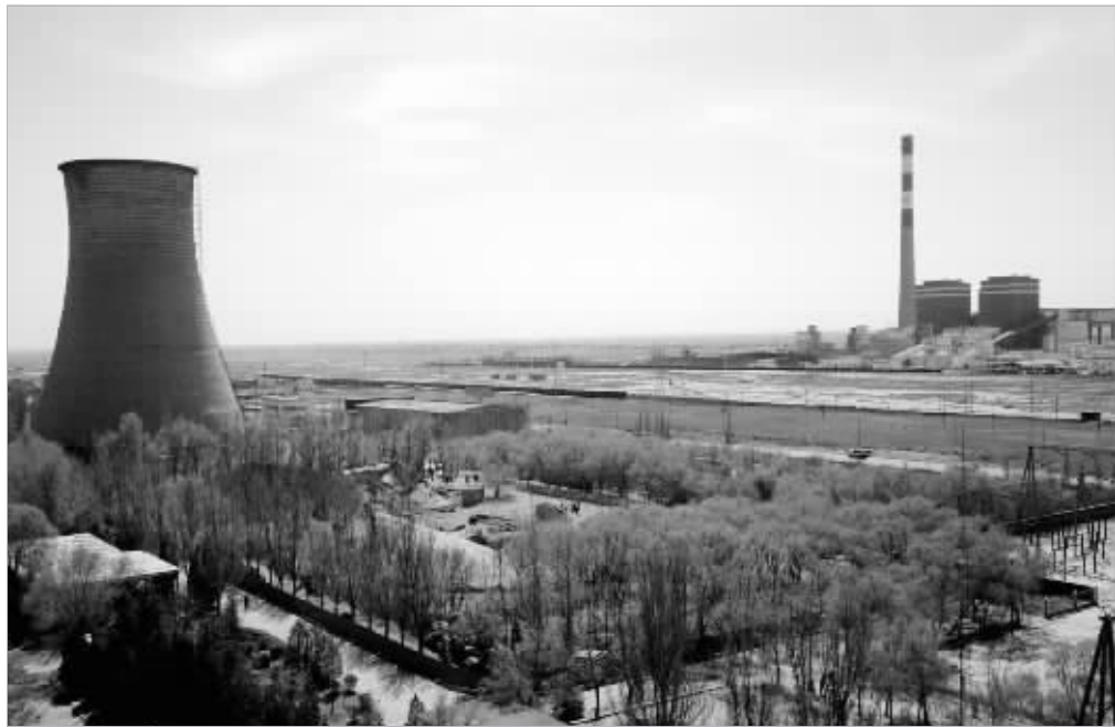
一季度高耗能高污染行业增长过快,再次敲响了节能减排的警钟。图为待拆除的小火电厂 新华社图
