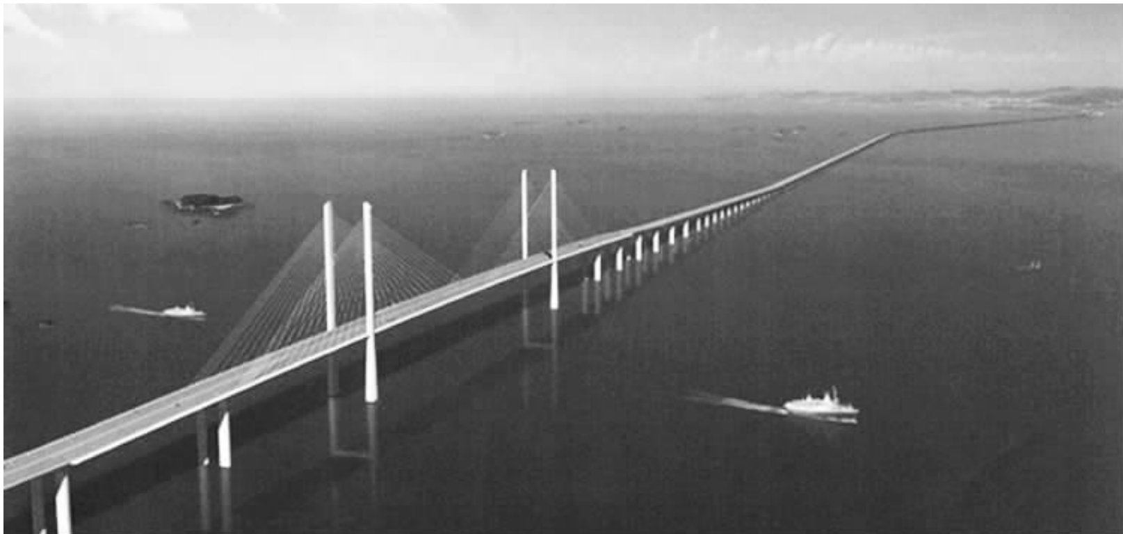
虽然主桥梁架架设已全部完成，但由于大桥还要铺沥青，以及装设护栏等，真正通车估计要到明年奥运会之前 资料图
