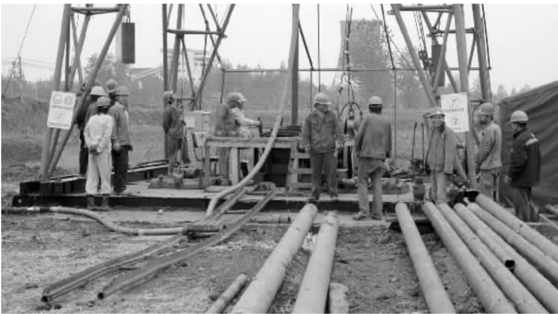
我国首个煤层气项目钻孔施工现场 资料图
