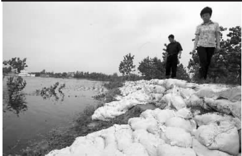
淮河防汛抗洪形势严峻,一些基层干部坚守抗洪抢险一线,巡查大堤 新华社图
