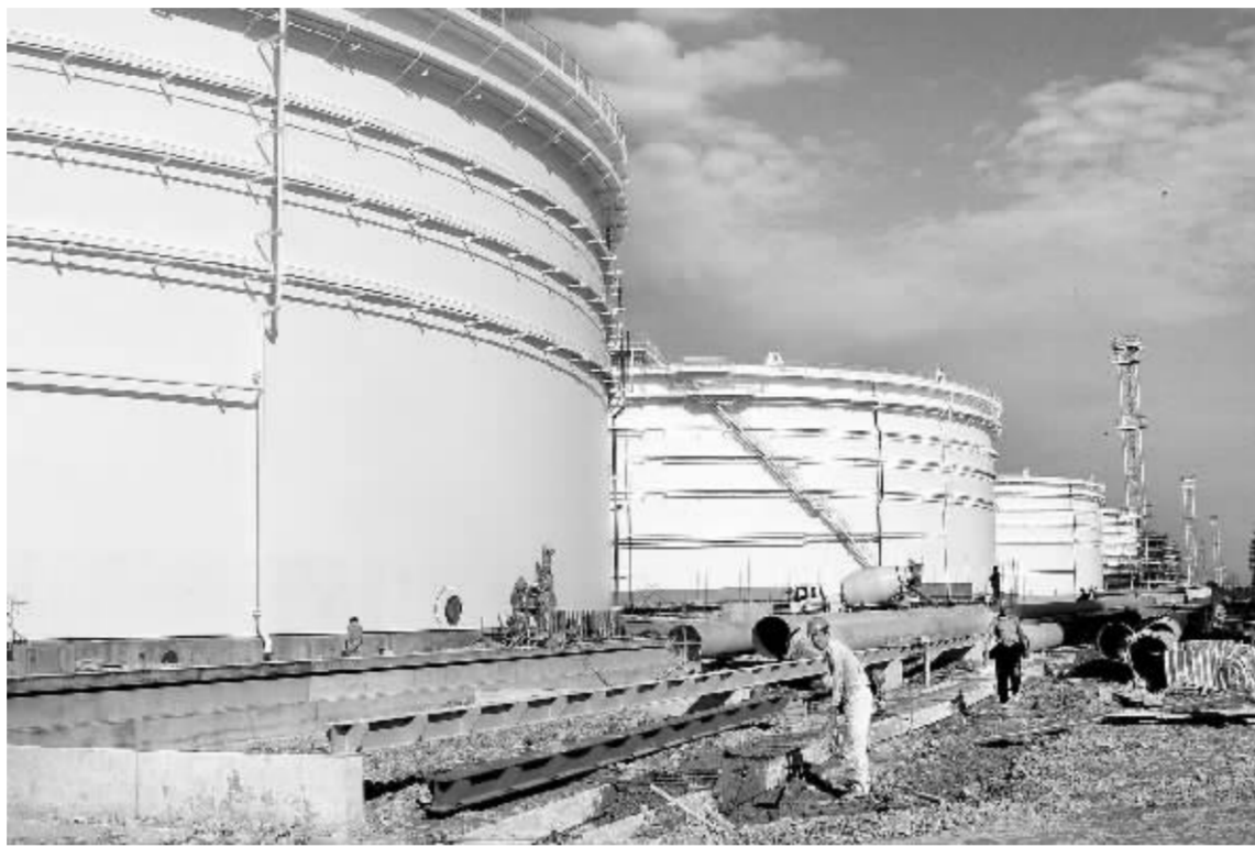
建设中的石油储备基地 资料图
