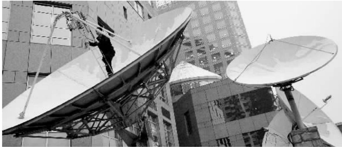
工作人員在檢修衛星通信地面天線 資料圖
