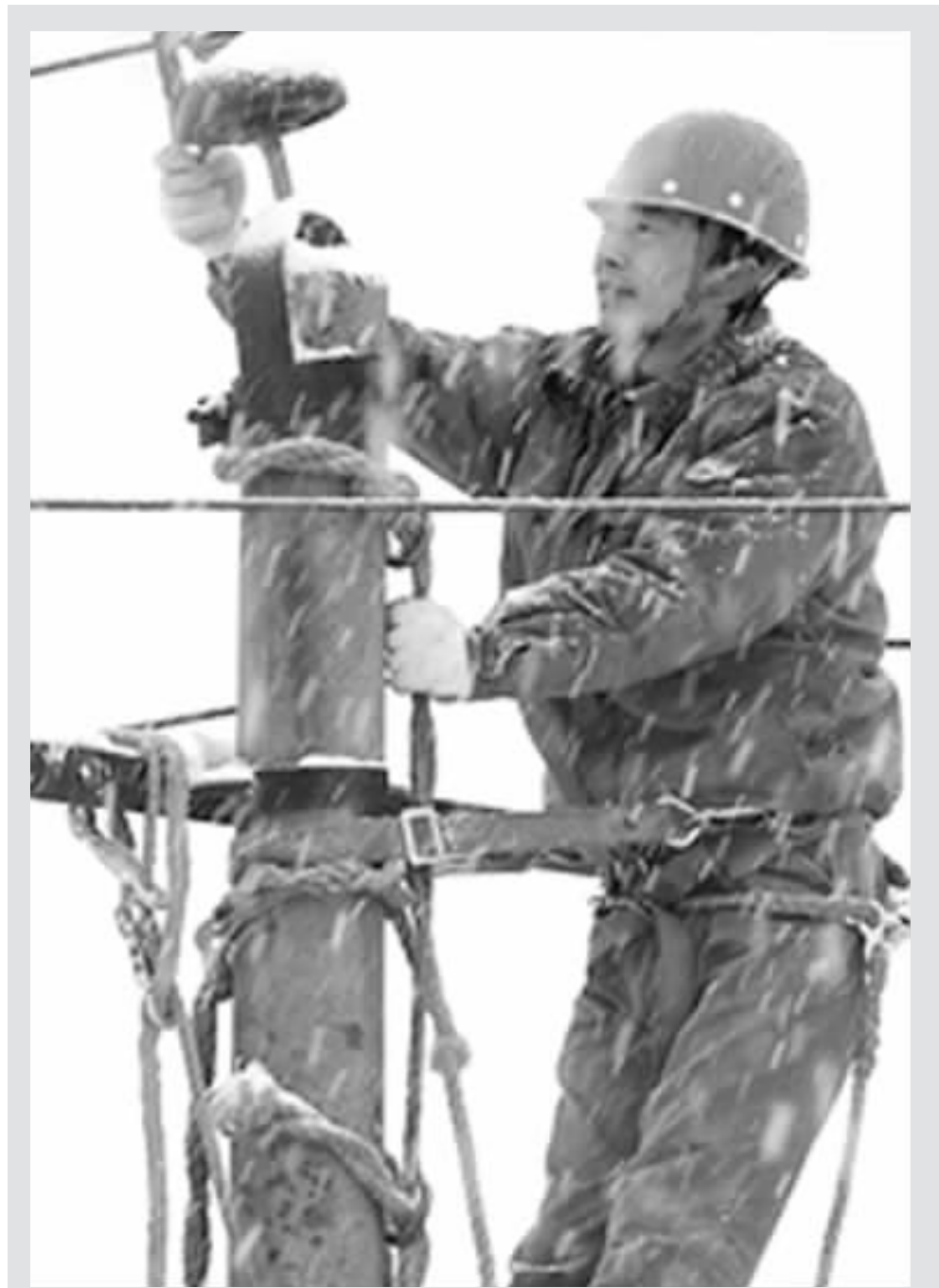
1月28日,安徽宣城供电公司水东供电所员工冒着大雪抢修线路 新华社图
