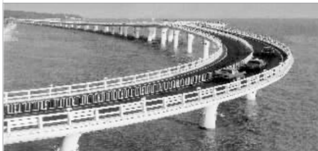
中国铁建承建的厦门海湾大桥
