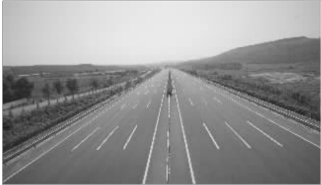
中国铁建承建的沈大高速公路某标段
