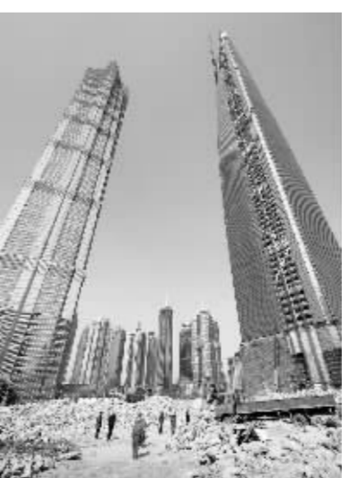
图为工人们日前在“上海中心”工地上进行开工前准备 新华社图
