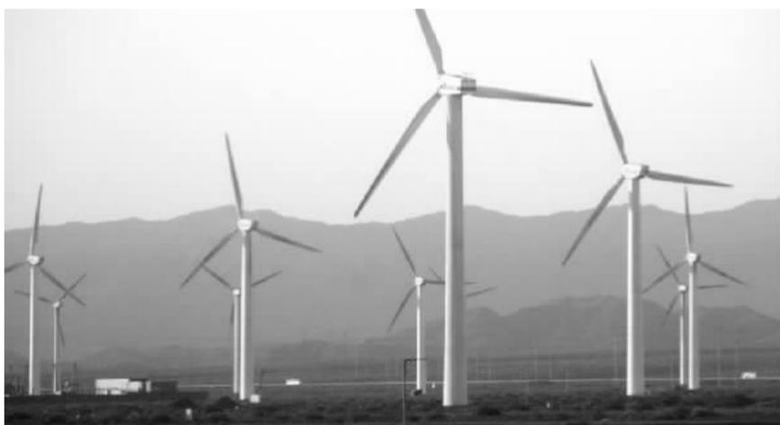
彰武马鞍山风电项目。该地区邻近马山上要投建的彰武曲家沟风电场,场区规划面积为 13 平方公里,其风能资源达 3 级以上。该项目装机容量为 49.5MW,采用 1500KW 型的风力发电机组,年上网电量为每小时 11303 千瓦。该工程预计于今年 8 月开工,至 2009 年 8 月底全部建成。
