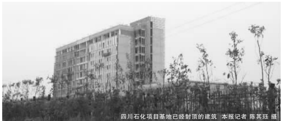
四川石化项目基地已经封顶的建筑 本报记者 陈其珏 摄
