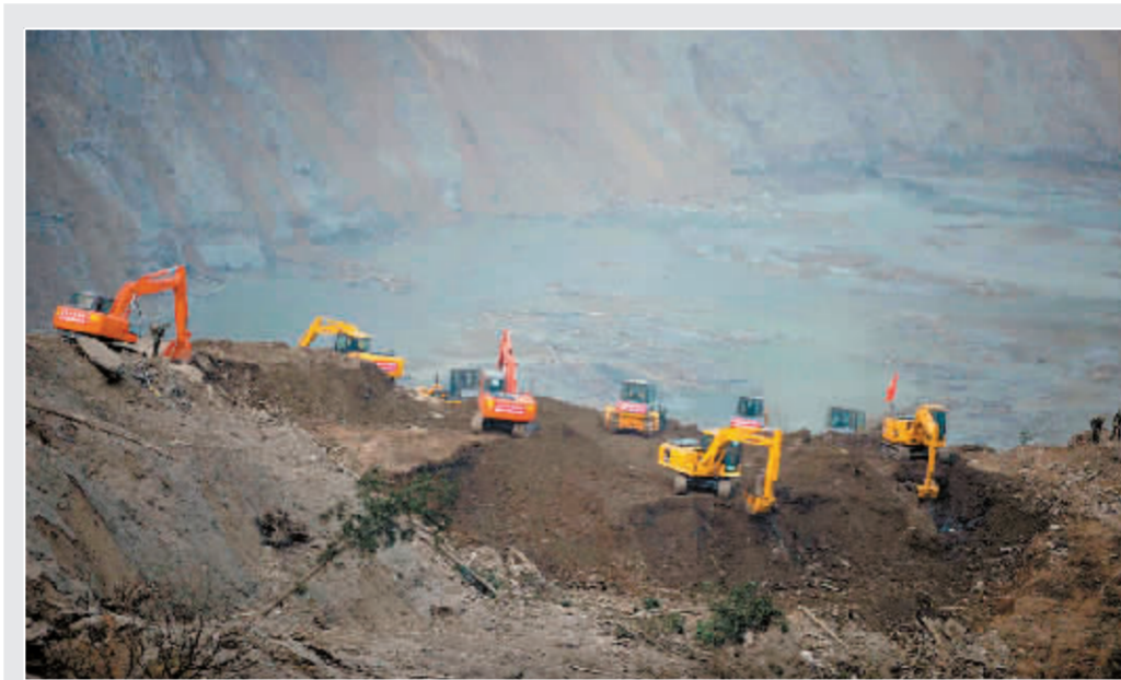
5月26日, 随着大型机械的运入, 四川绵阳唐家山堰塞湖抢险工程全面展开 新华社图
