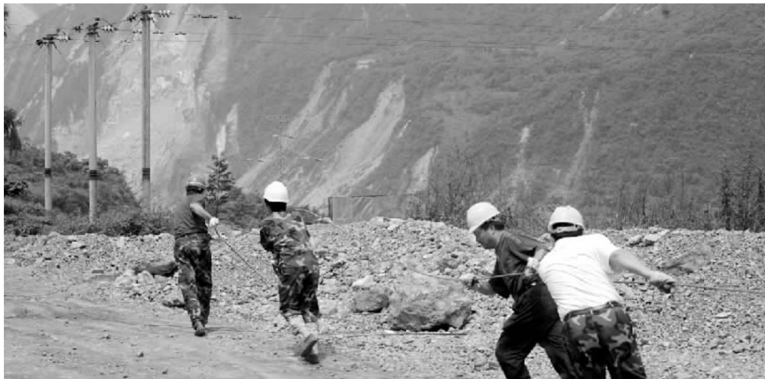
6月2日,汶川县电力公司职工正在架设电力线路 新华社图
