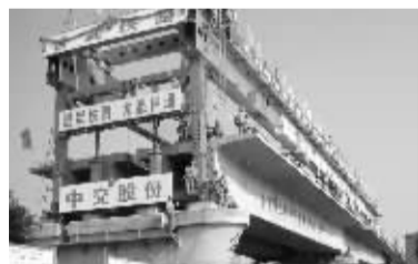
中交承建的合武铁路工程
