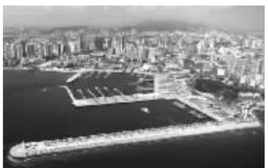
中交承建的奥运工程青岛奥帆基地
