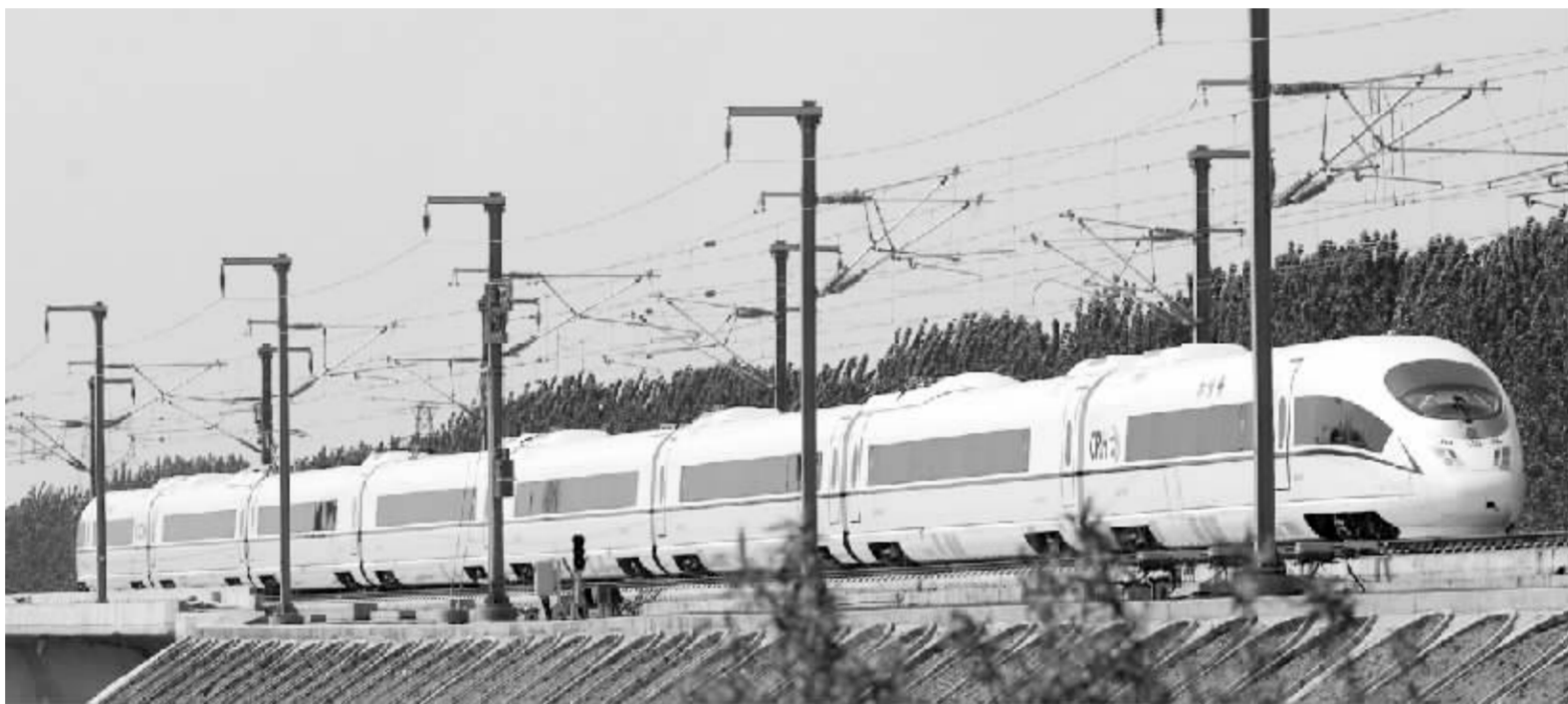
CRH3“和谐号”动车组沿京津城际铁路试运行 资料图
