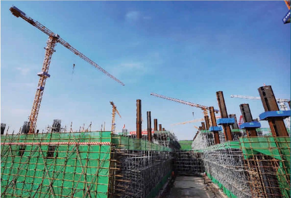
建设中的高铁雄安站
