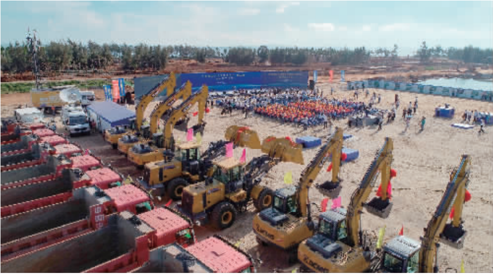
9月13日拍摄的海南自由贸易港建设项目（第三批）集中开工仪式现场（无人机照片）。 新华社图
