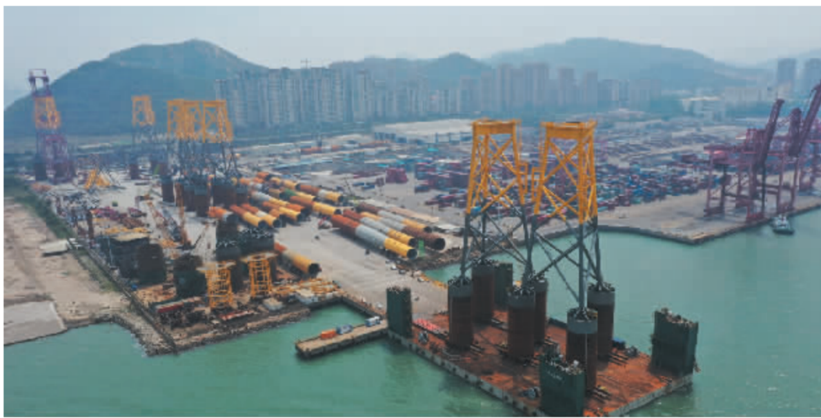
中信重工漳州新能源装备基地
