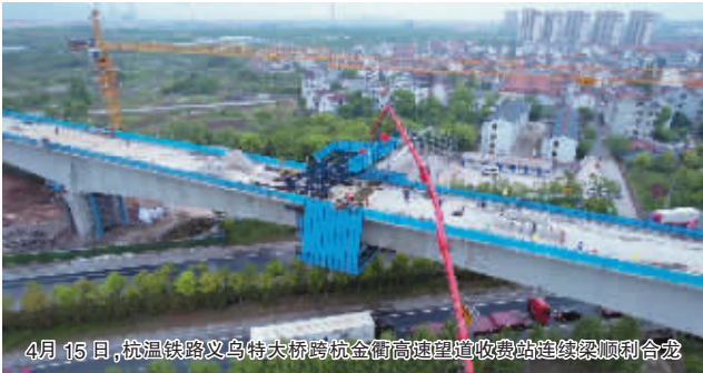
4月15日,杭温铁路义乌特大桥跨杭金衢高速望道收费站连续梁顺利合龙
