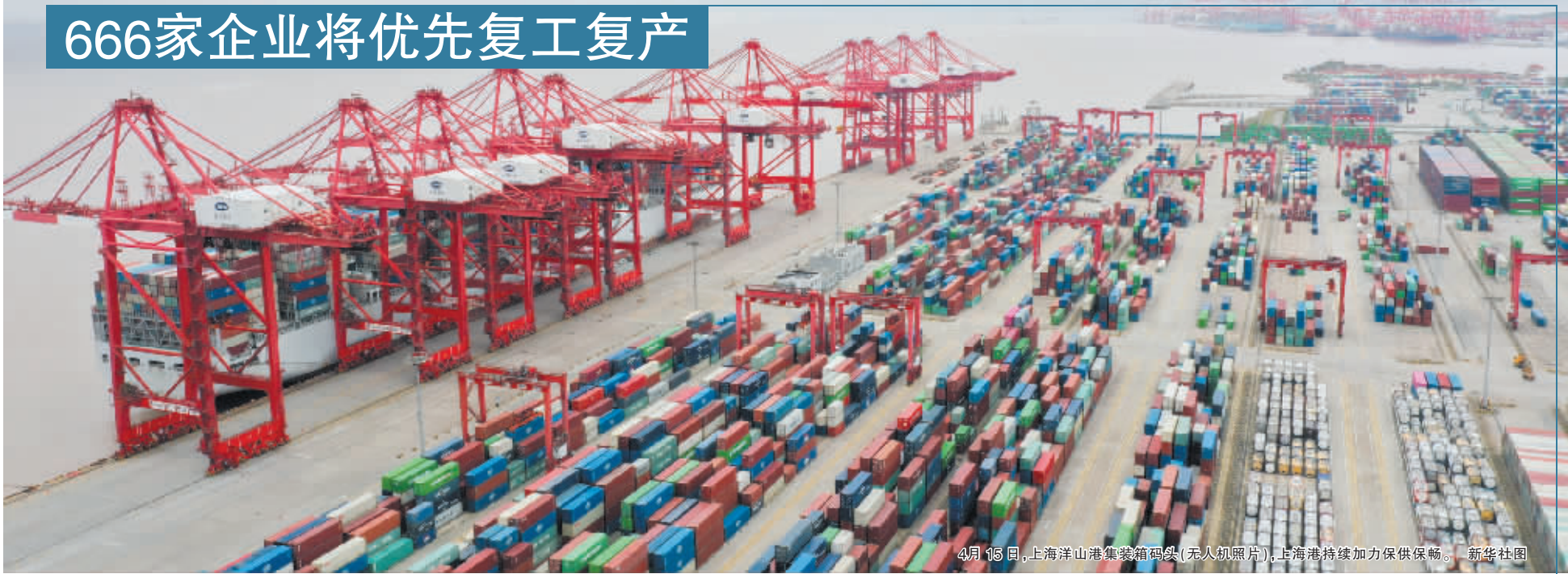
4月16日,上海洋山港集装箱码头(无人机照片),上海港持续加力保供保畅。 新华社图
