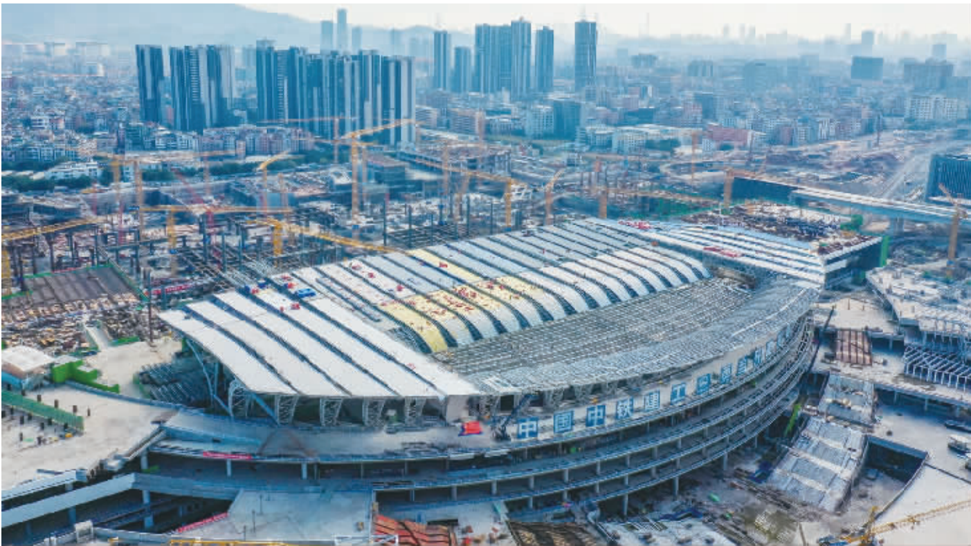
近日，中铁建工承建的广州白云火车站项目建设快速稳步推进，目前正进行一期金属屋面和二期主体结构施工。
