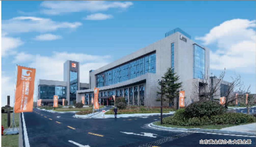
山东黄金新办公大楼全景
