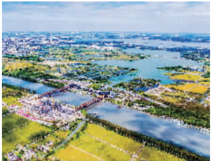
建设中的方厅水院
