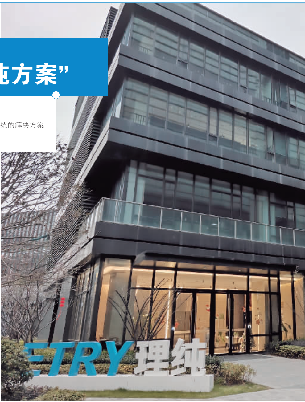
理纯办公大楼
