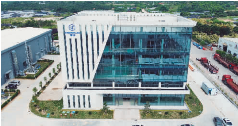
漳州工厂二期办公大楼
