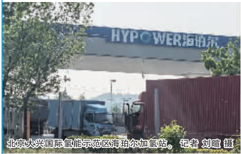
北京大兴国际氢能示范区海珀尔加氢站。 记者 刘旭 摄
