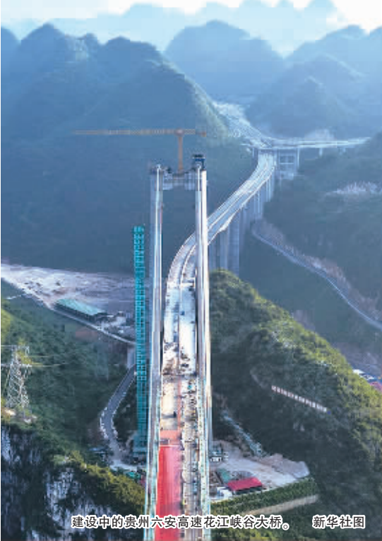
建设中的贵州六安高速花江峡谷大桥。 新华社图
