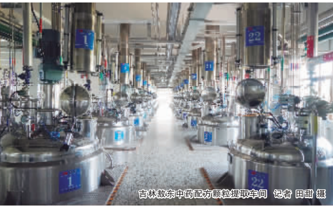
吉林敖东中药配方颗粒提取车间 记者 田甜 摄
