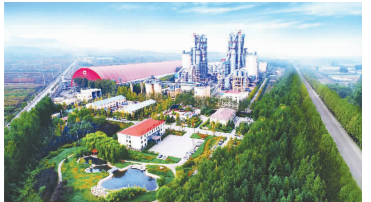
全球水泥行业全氧燃烧耦合碳捕集技术领域规模最大项目之一——青州中联CCUS工业示范项目,年捕集量20万吨
