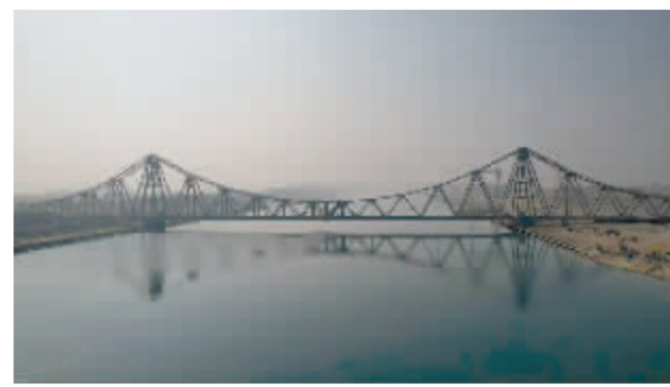
埃及苏伊士运河EL-FERDAN大桥项目
