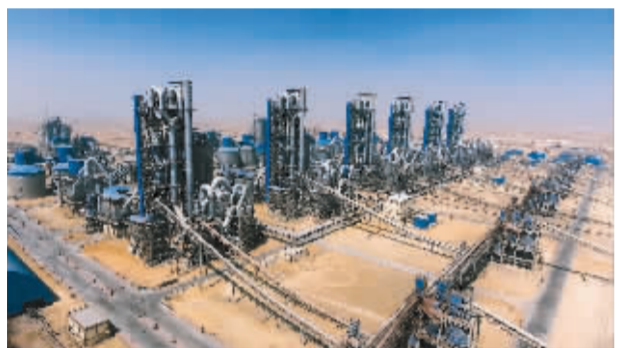
埃及GOE 6x6000TPD水泥生产线项目,被誉为“水泥王国的金字塔”
