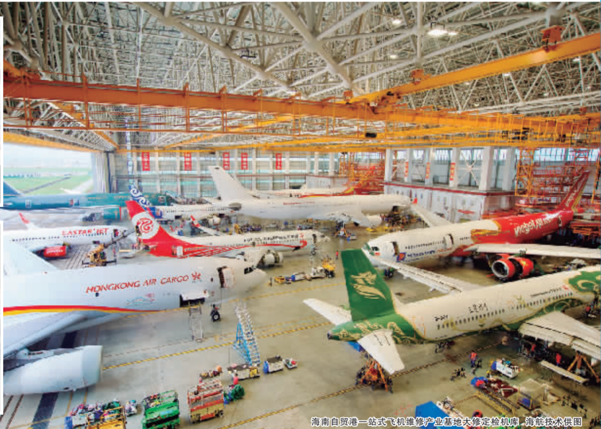
海南自贸港一站式飞机维修产业基地大修定检机库。海南航空供图
