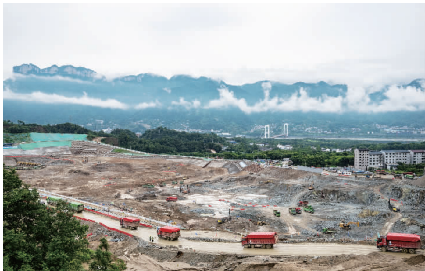
这是6月8日拍摄的三峡水运新通道工程先行开挖区施工现场。6月8日,我国“十五五”期间开工建设的首个国家重大标志性工程——三峡水运新通道破土动工,该工程建成后有利于提升长江黄金水道通航能力。
