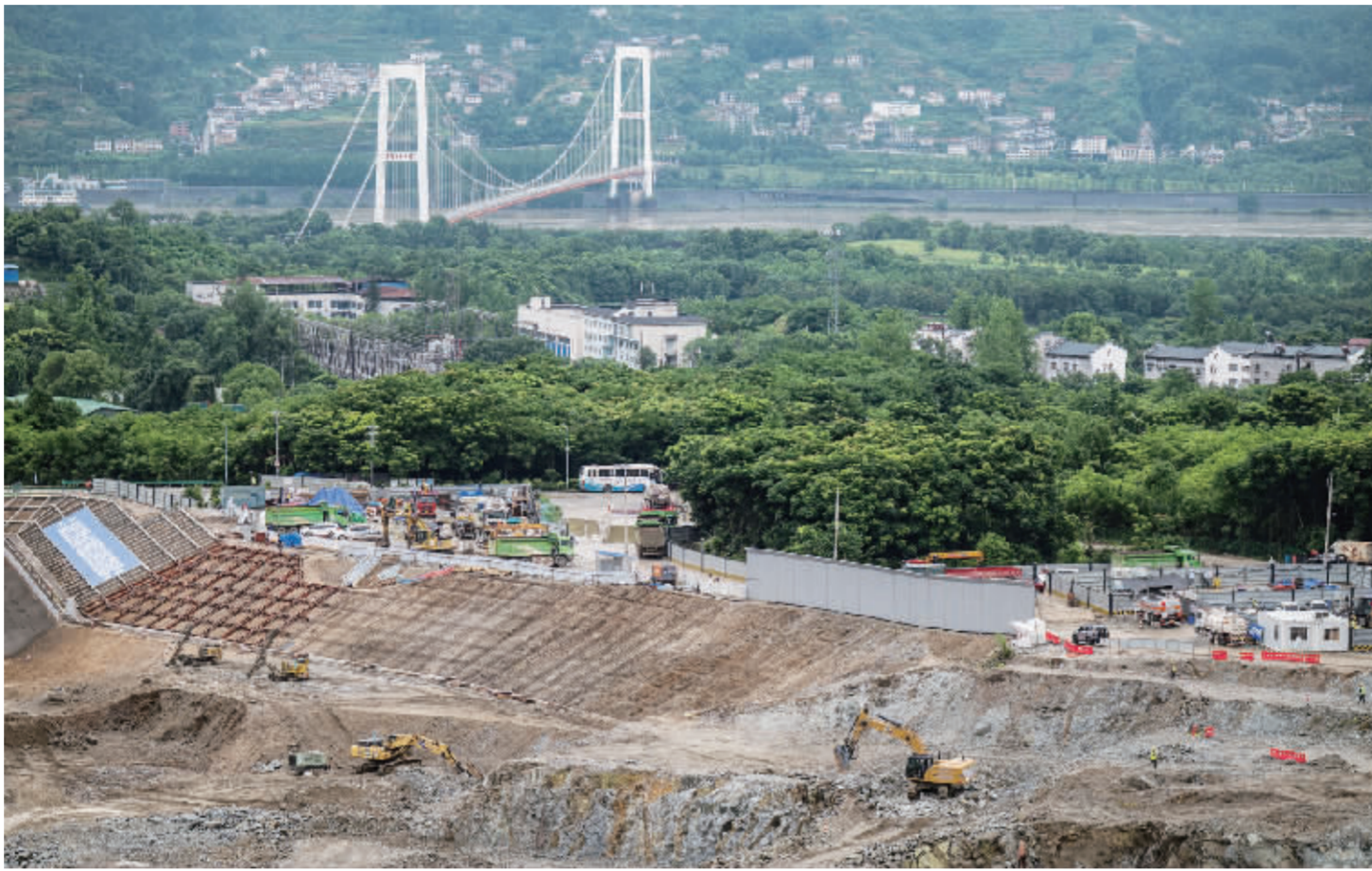
6月8日，三峡水运新通道工程先行开挖区施工现场。新华社图
