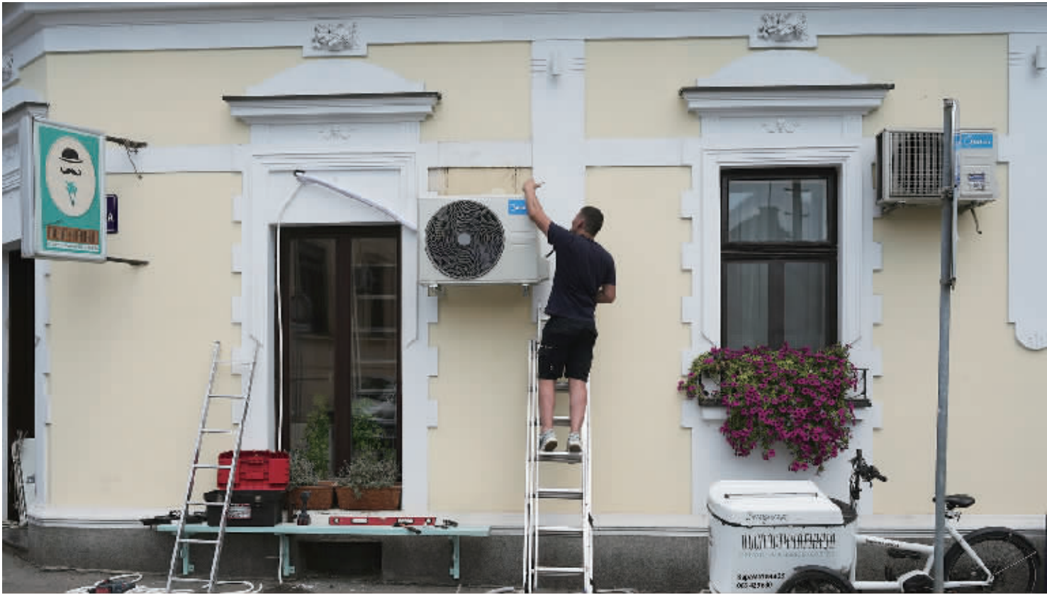
当地时间2026年6月30日，塞尔维亚贝尔格莱德，一名安装人员在炎热的夏日安装新的空调设备
