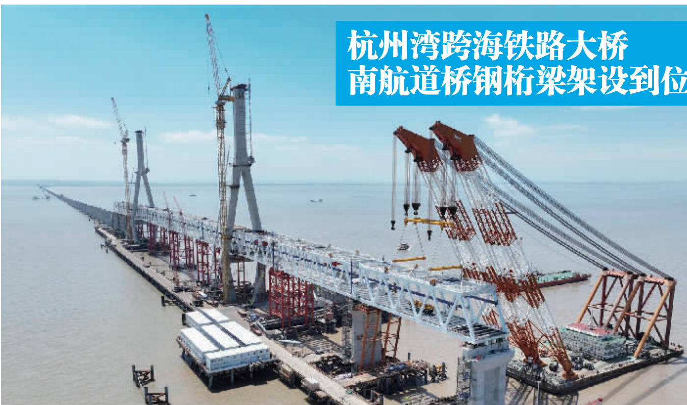
7月26日拍摄的杭州湾跨海铁路大桥南航道桥钢桁梁架设现场。7月26日，由中铁上海建设公司建设管理、中交二航局承建的杭州湾跨海铁路大桥南航道桥钢桁梁全部架设到位，标志着这一工程建设取得阶段性进展。杭州湾跨海铁路大桥是新建南通至宁波高速铁路关键控制性工程，全长29.2公里，采用时速350公里双线无砟轨道设计，由北、中、南三座航道桥及海中引桥、浅滩区引桥共同组成。
