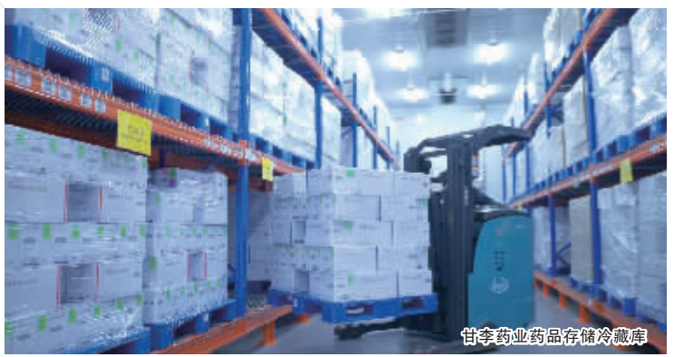
甘李药业药品存储冷库
