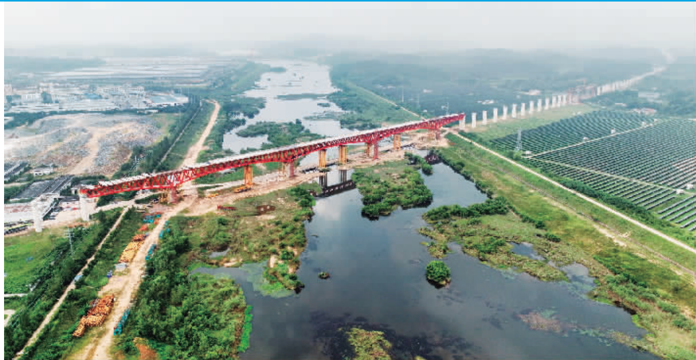
8月21日,由皖赣铁路安徽公司建设管理、中铁十一局承建的合武高铁金寨史河特大桥钢桁梁主体工程完工。金寨史河特大桥位于安徽省六安市金寨县,主桥钢桁梁全长540米,采用上承式双结合连续钢桁梁结构形式,是合武高铁安徽段重难点工程。合肥至武汉高速铁路是我国“八纵八横”高铁网沿江通道的重要组成部分,设计时速350公里。线路建成后,将在合肥至武汉间形成新的高铁大通道,进一步优化长江经济带铁路网布局。
