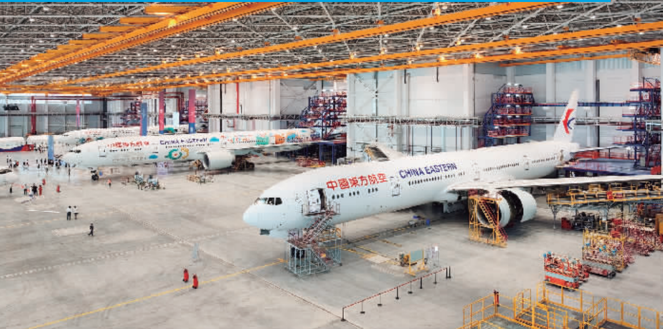
记者从中国东航获悉,亚洲最大宽体机维修机库9月2日在上海投入运营。该机库大厅可以同时容纳9架宽体机和2架窄体机开展整机维修作业。图为9月2日拍摄的亚洲最大宽体机维修机库。
