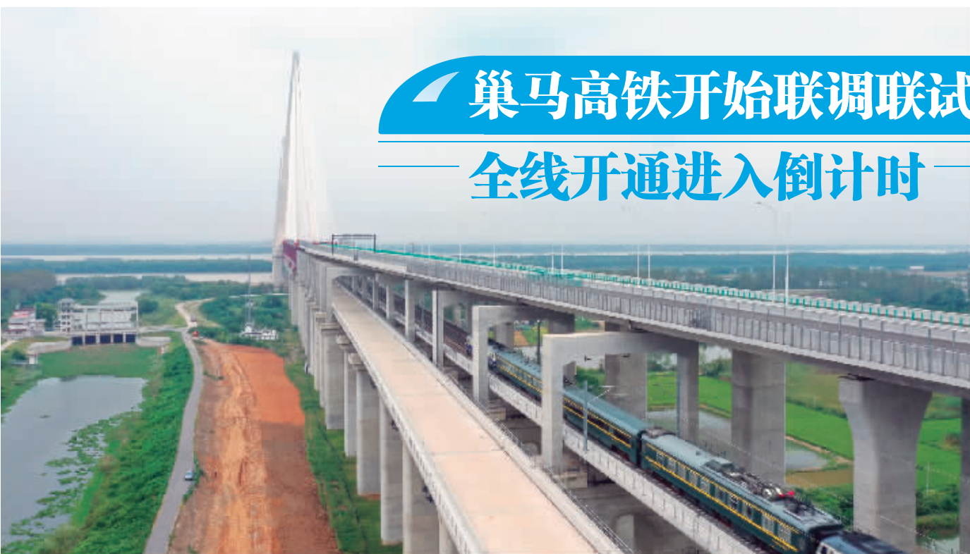
9月11日，首趟检测列车从安徽巢湖东站开出，驶向马鞍山站方向进行轨道和接触网检测，标志着新建巢马至马鞍山城际铁路（简称巢马高铁）开始联调联试，全线开通运营进入倒计时。巢马高铁是合肥与马鞍山间直达高铁线路，项目建成后，将在皖江两岸建起一条快速新通道，对于完善区域路网布局，打造“轨道上的长三角”，服务长三角一体化发展和长江经济带发展等具有重要意义。图为检测列车驶过巢马高铁马鞍山长江公铁大桥。
