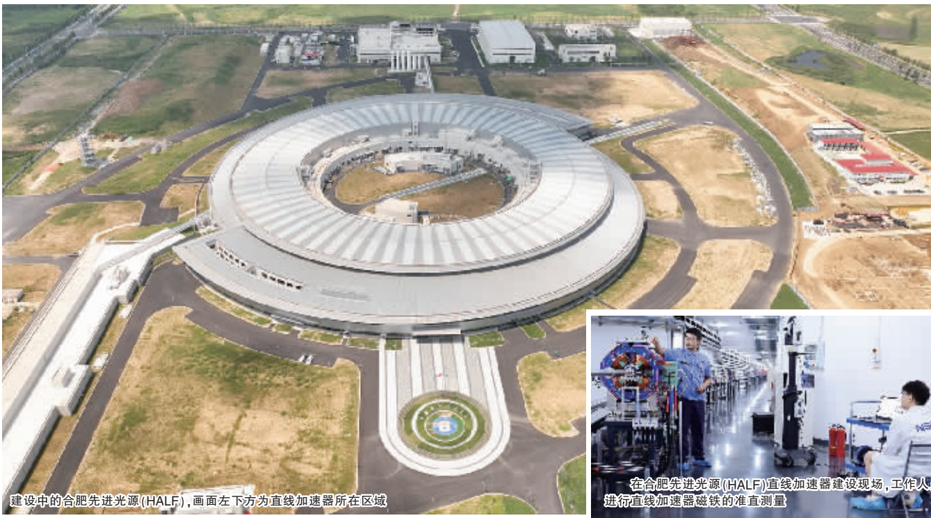
建设中的合肥先进光源（HALF），画面左下方为直线加速器所在区域
